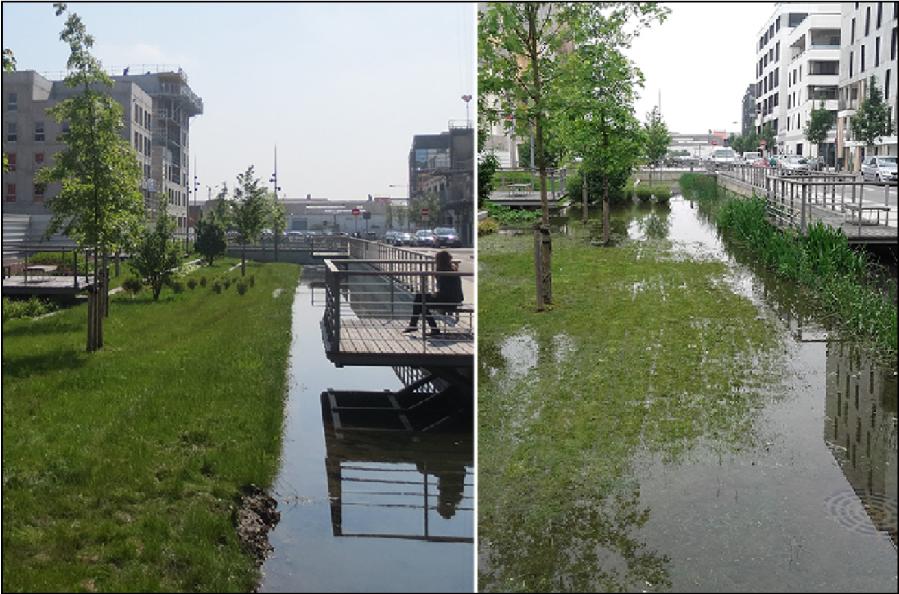
Noue sur le quartier de la Luciline recueillant la rivière du même nom, les eaux pluviales du quartier et qui fait office de bassin de rétention dès que les ouvrages d'assainissement sont en charge. Photo de gauche : fonctionnement classique / photo de droite : mis en charge de la noue due au phénomène de crue, d'eau de ruissellement et de remontée de nappe en juin 2016.
